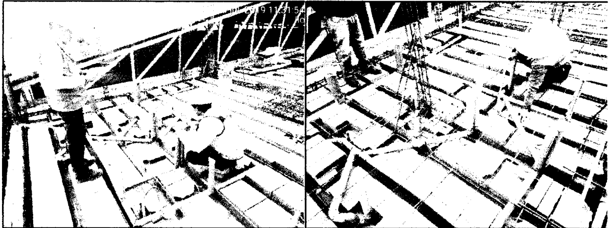
Foto N° 13 y 14: Acometida de tubería para instalaciones sanitarias en el bloque de Administración.
