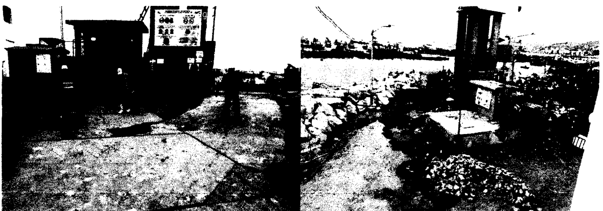
Foto N° 17 y 18: Partida N° 01.04 "Patio de despacho directo", 01.04.01 "movimiento de tierra", que intentaron sorprender ser valorizadas sin ejecutar: en este sentido se muestra fotos del area donde se construira el Patio de despacho directo, no viendose excavación alguna, mucho menos eliminación de excavación
